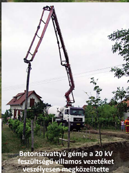
Betonszivattyú és mixerkocsi a 20 kV feszültségű villamos vezeték alatt
